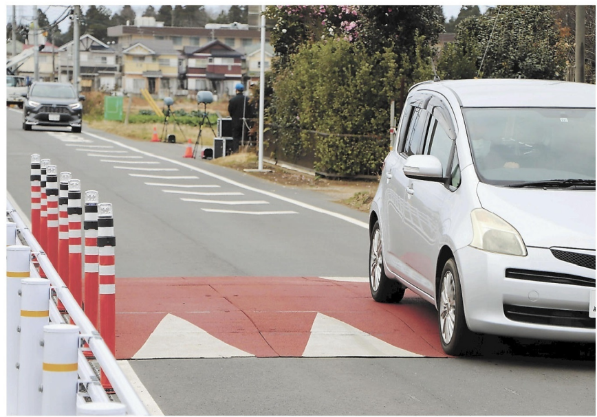
事故現場付近に設置された「ハンプ」=7日、千葉県八街市
